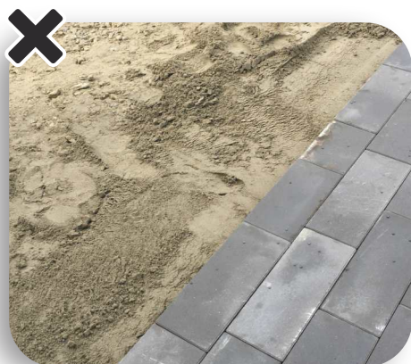
PODŁOŻE KOSTKI WYKONANE Z PODSYPKI CEMENTOWEJ
