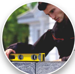
SPRAWDZANIE ODCHYLEŃ
