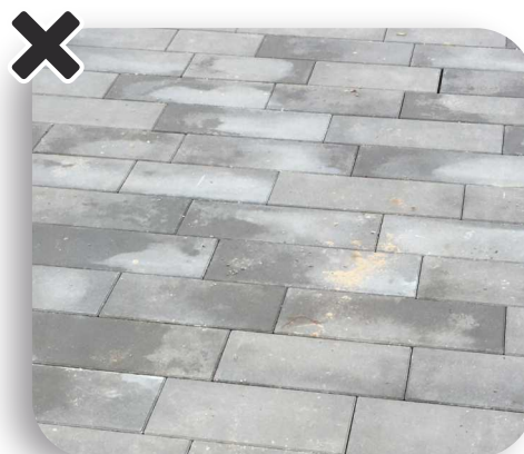
NA KOSTCE POJAWIA SIĘ BIAŁY NALOT (WYKWIT) Z POWODU ŹLE WYKONANEJ PODBUDOWY
