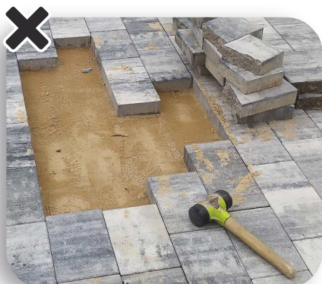
PODŁOŻE KOSTKI WYKONANE Z ŻÓŁTEGO PIASKU
